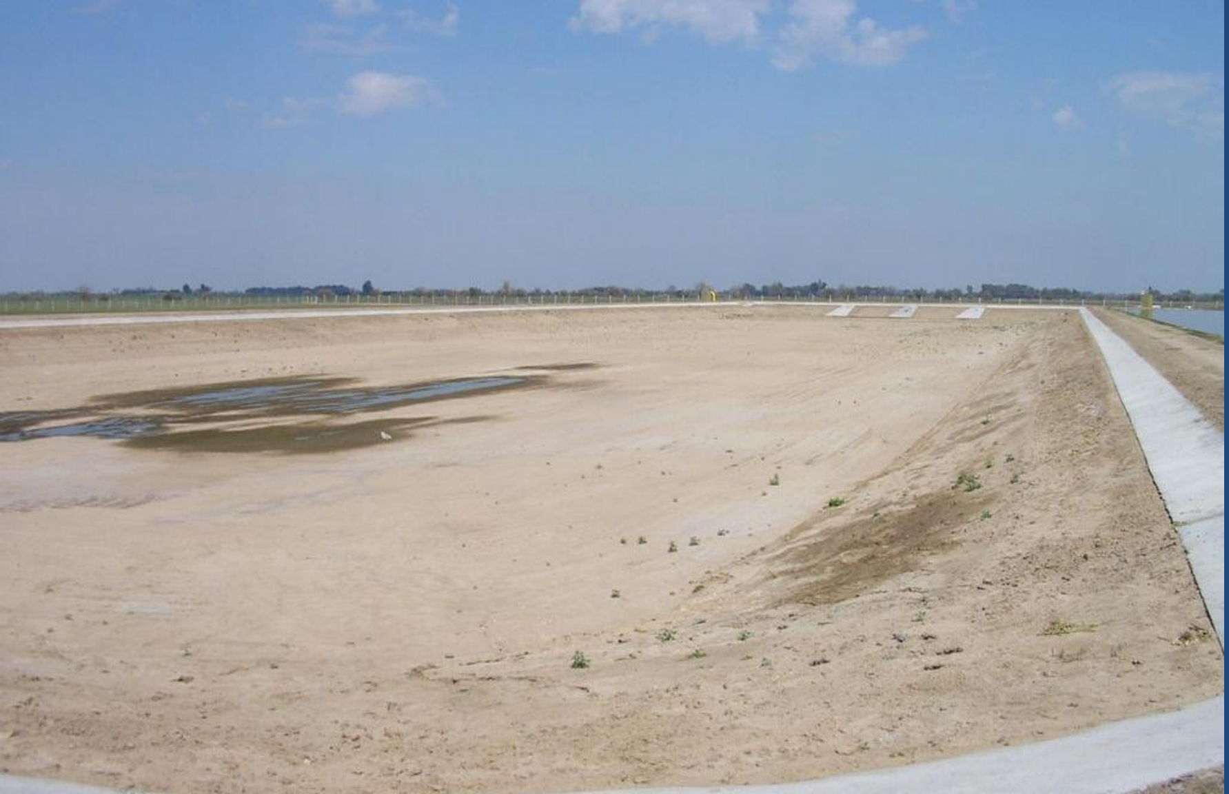
Vista de las Lagunas Sanitarias
