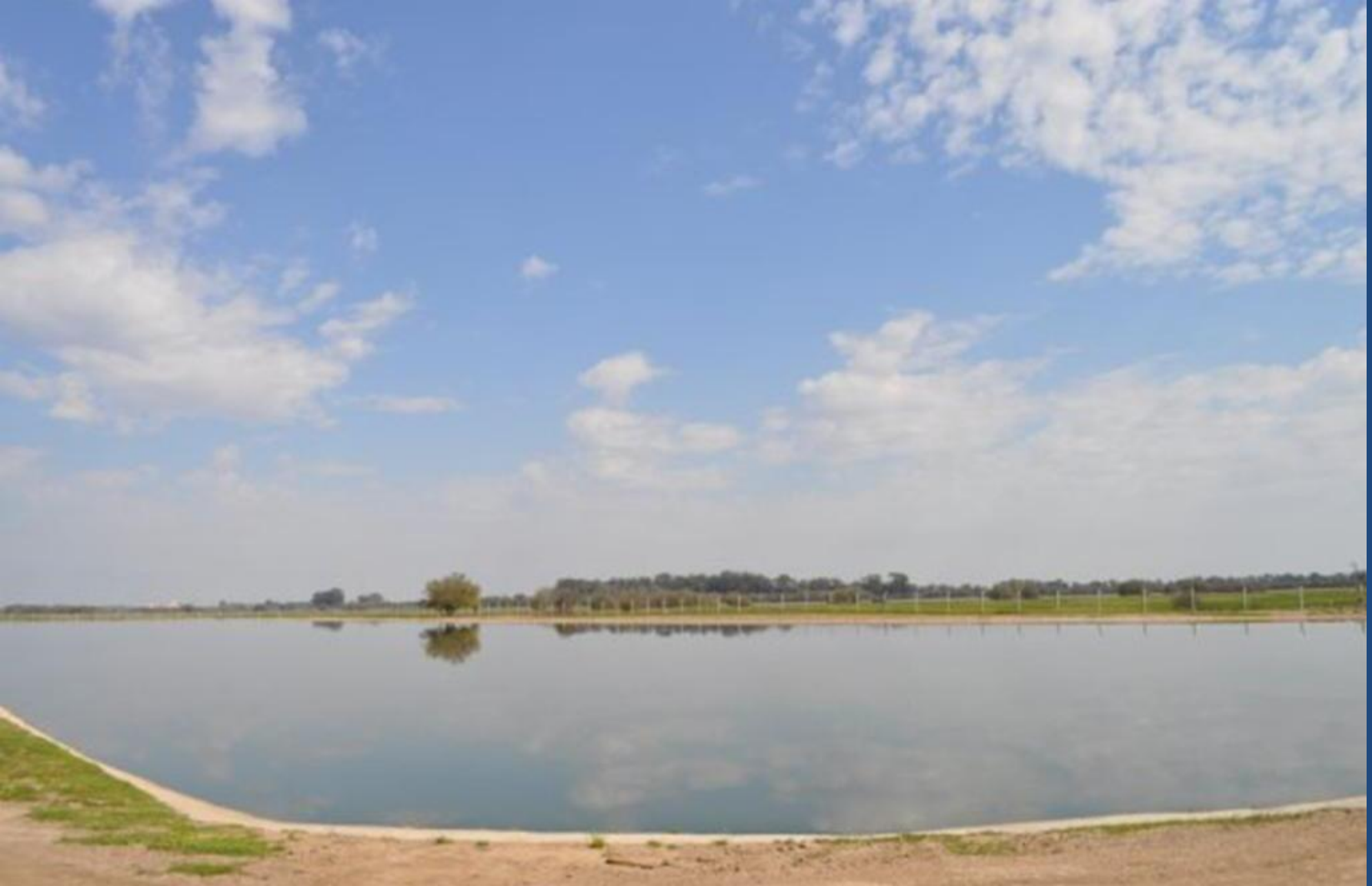
Vista de las Lagunas Sanitarias
