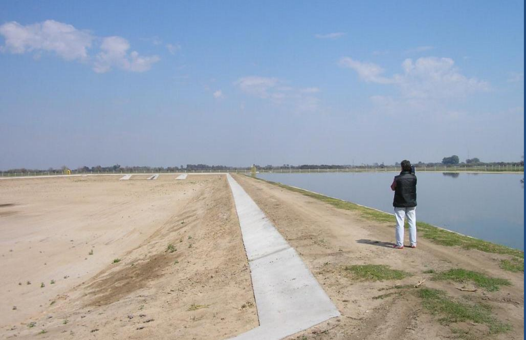
Vista de las Lagunas Sanitarias
